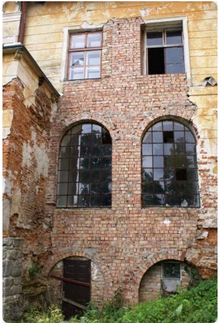
Fotografia ściany północnej w 2005 r. po tzw. "odbudowie"
