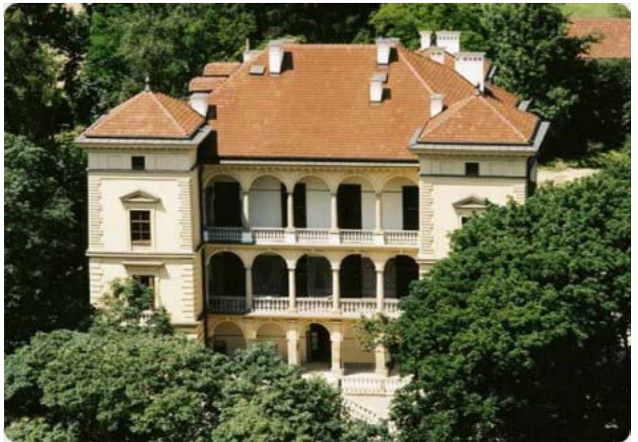
Willa Deciusza po odbudowie
